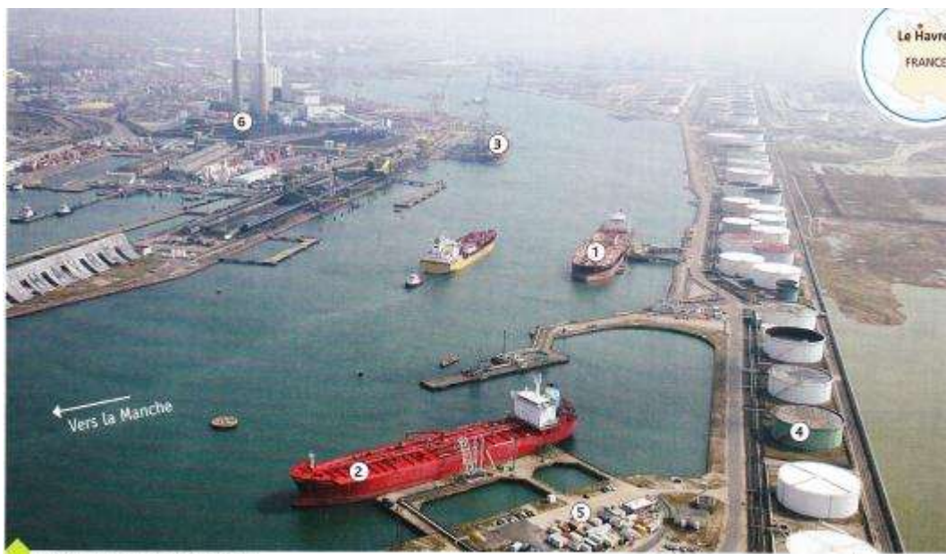
1 L'entrée du port du Havre. ① Pétrolier. ② Porte-conteneurs. ③ Vraquier déchargeant du charbon. ④ Cuve de stockage du pétrole. ⑤ Quai de déchargement et de stockage des conteneurs. ⑥ Centrale thermique.
