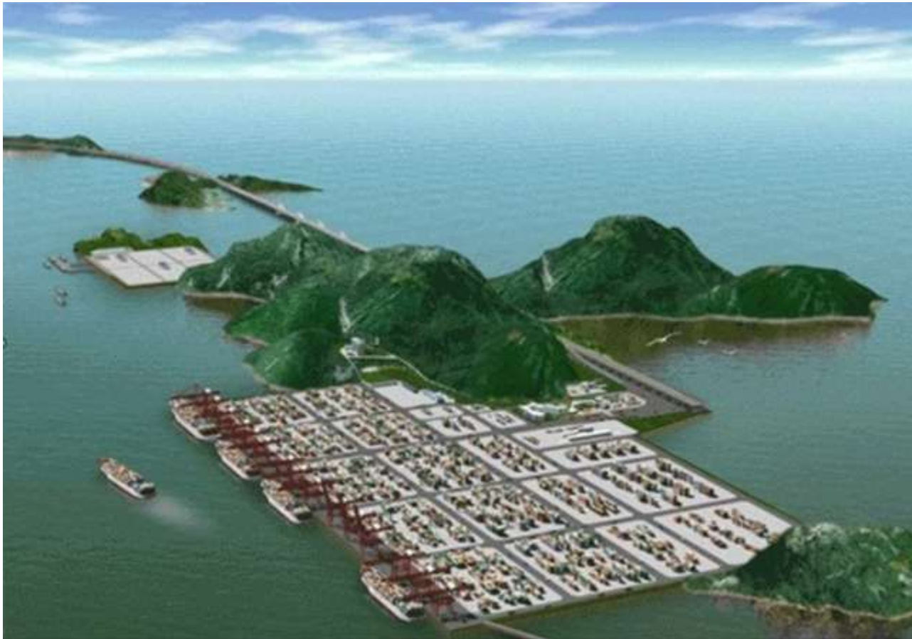
Nouveau port en eau profonde de Shanghai
